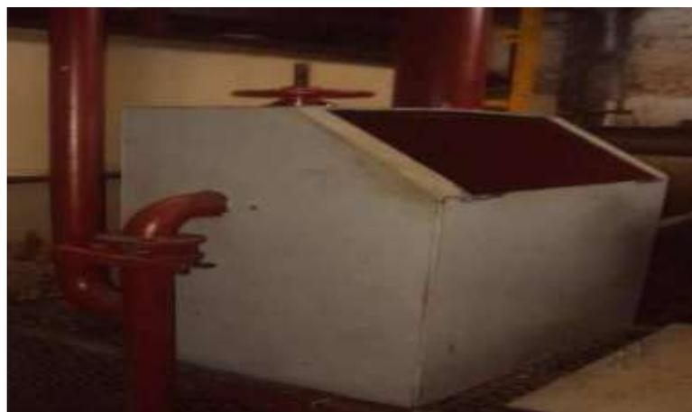
**Figura 19.** Caixa de recepção de lodo
