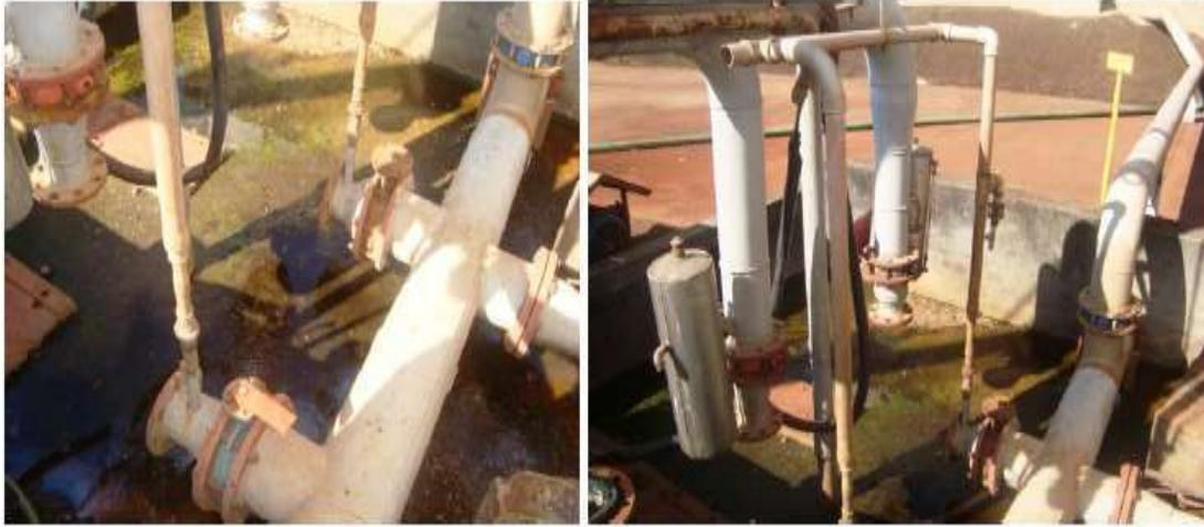
**Figura 20.** Sistema de bombeamento de melaço
