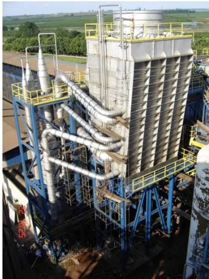
Figura 32: Condensador Evaporativo. Fonte: LM Engenharia
