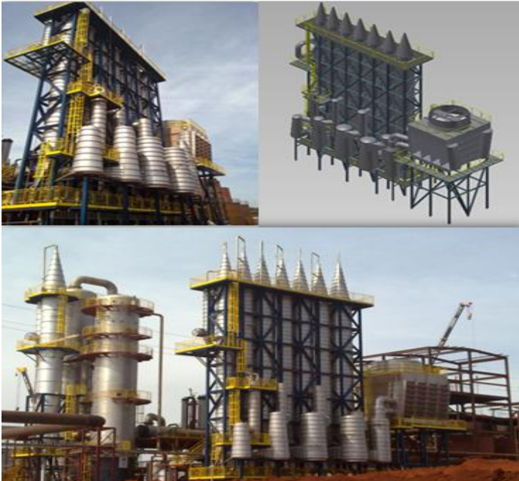
Figura 17. ECOVIN – Evaporador de concentração vinhaça de múltiplos efeitos. Fonte: GUARANI (2011).
