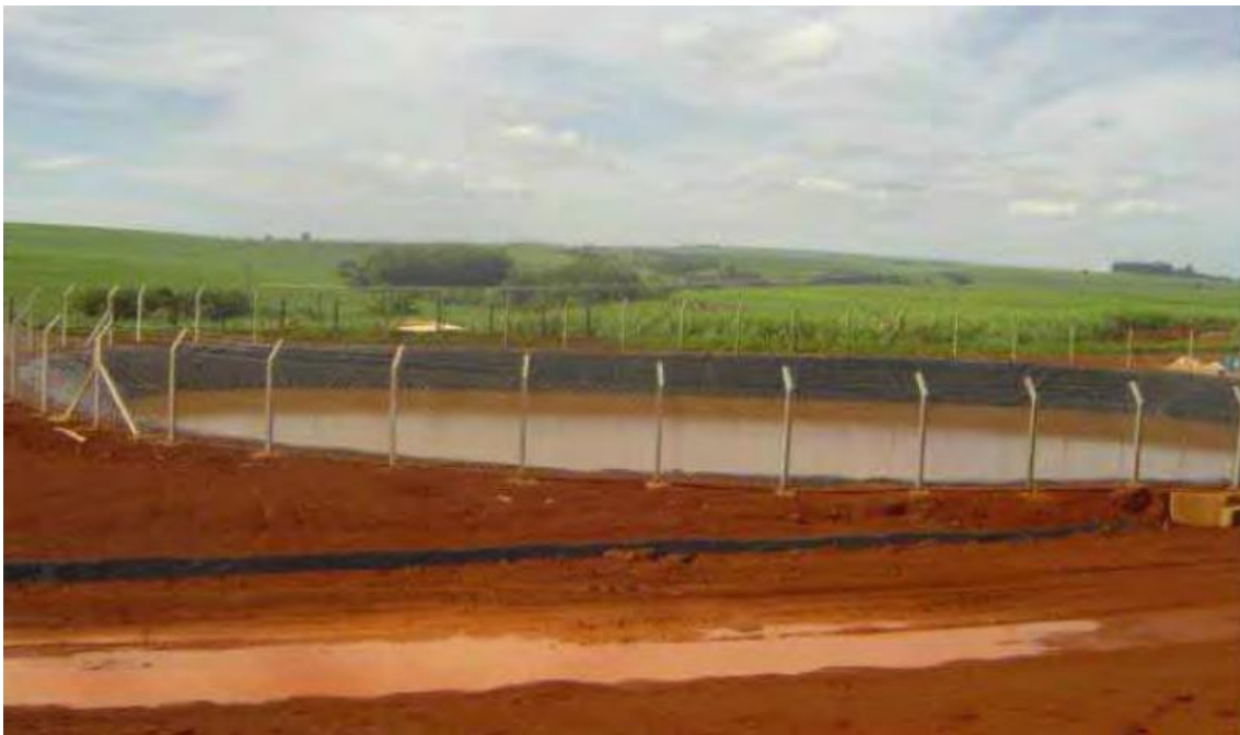
Figura 11 - Depósito de vinhaça impermeabilizado. Fonte: CARVALHO (2010).
