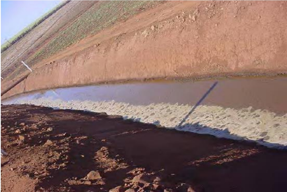
Figura 5 – Foto de um canal condutor de vinhaça. Fonte: CARVALHO (2010).
