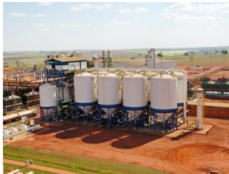
Figura 6: Processo Industrial de Fermentação e Dornas. FONTE: SERMATEC, s/d.
